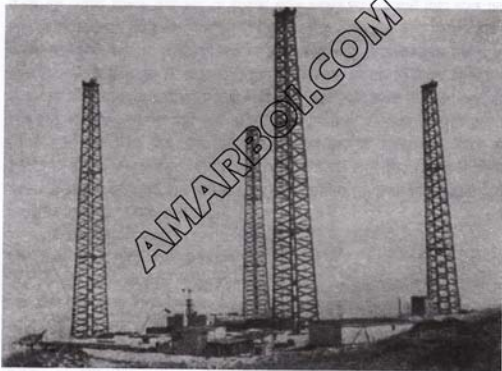
4.2 নং ছবি : 1901 সালে রেডিও সংকেত পাঠানোর জন্যে এন্টেনার উচ্চতা ছিল প্রায় দুইশ ফিট, বিদ্যুৎ লাগত 25 কিলোওয়াট
